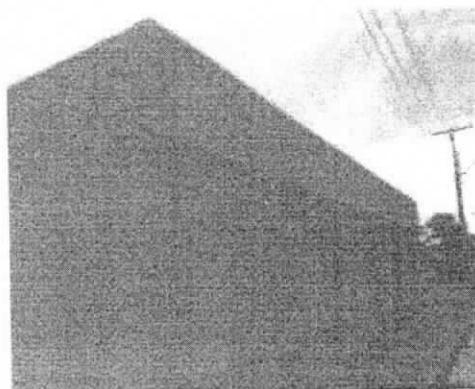
Imagem 4: Fachada Lateral - Rua 10
